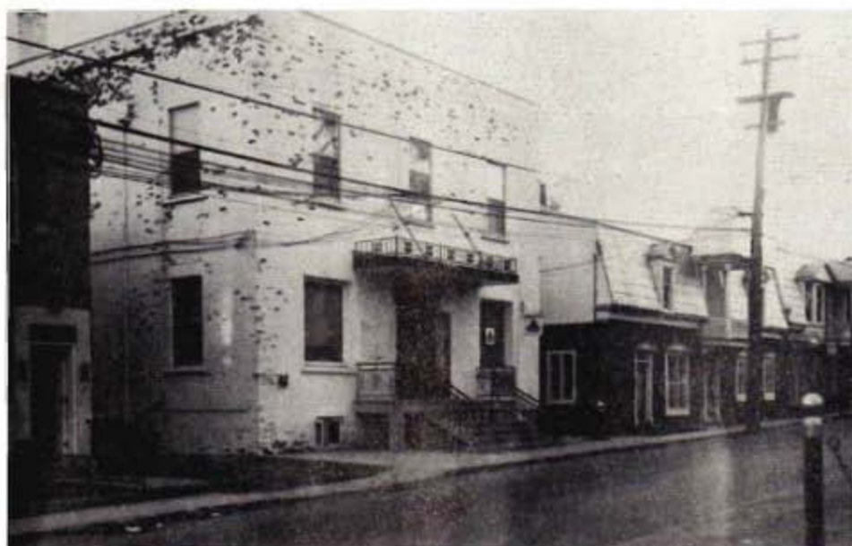
HOTEL DE VILLE DE SAINT-EUSTACHE peu de temps avant sa démolition pour faire place à un terrain de stationnement (photo fournie par M. Rolland Beauchamp)
